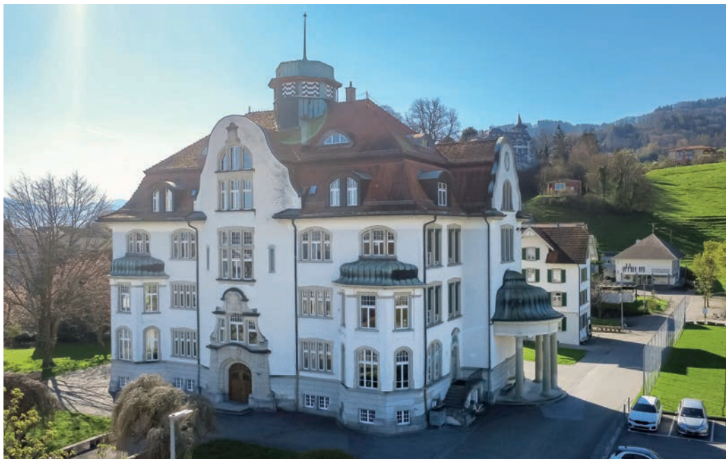
Das detailreich gestaltete Oberstufenschulhaus wurde zwischen 1905 und 1906 erbaut und gilt heute als typischer Vertreter des Schulhausbaus nach 1900.
