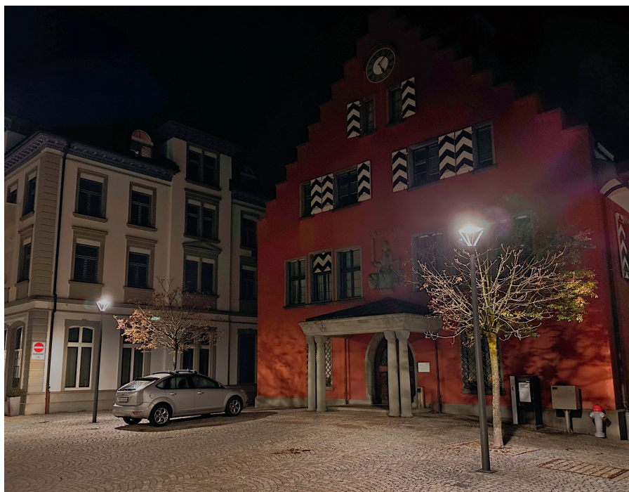
Auch auf dem Rathausplatz lässt sich ein markanter Unterschied feststellen. (Foto: Elektro Frei Rheintal AG)
