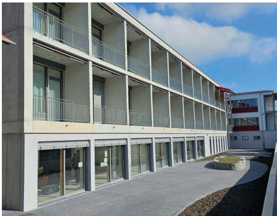
Das Pflegewohnheim Thal-Rheineck kurz vor Beendigung der Bauarbeiten.
