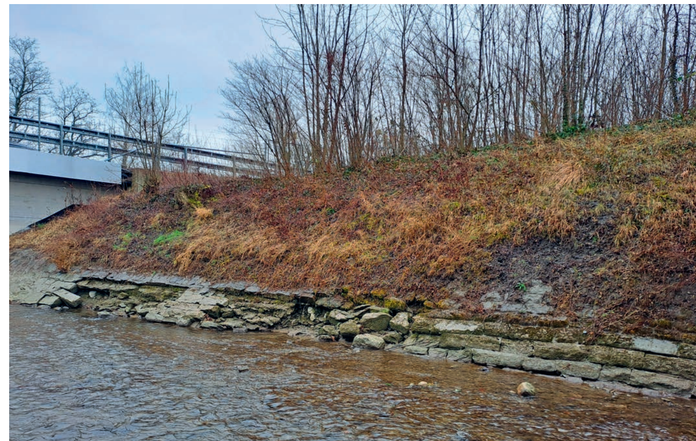
Der Hochwasserschutz am Freibach und Gstaldbach soll verbessert werden.
