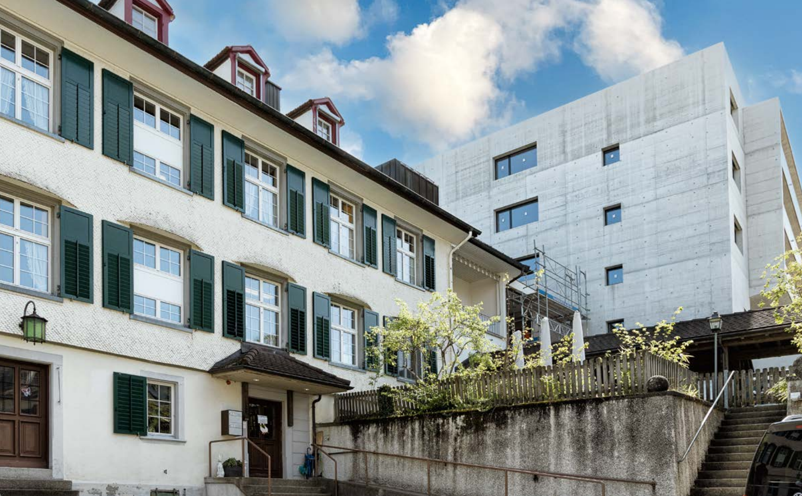
Nach der Fertigstellung des Neubaus wird der Altbau des «Altensteig» saniert.
