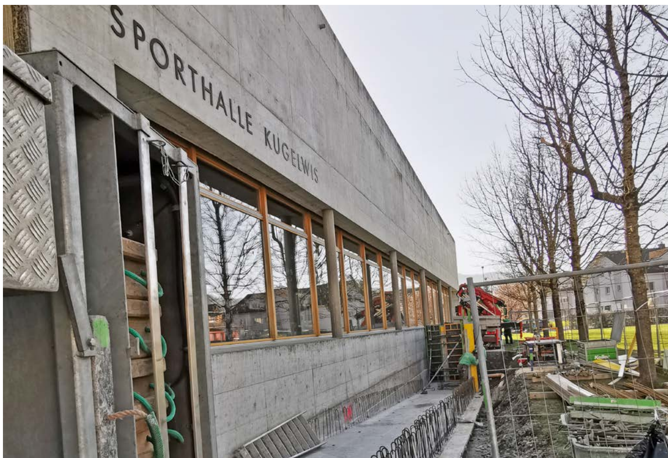
Die Arbeiten für den neuen Notausgang sind im vollem Gange.
