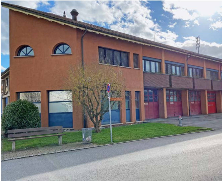
Die Umbauarbeiten im Mehrzweckgebäude sind bald abgeschlossen.
