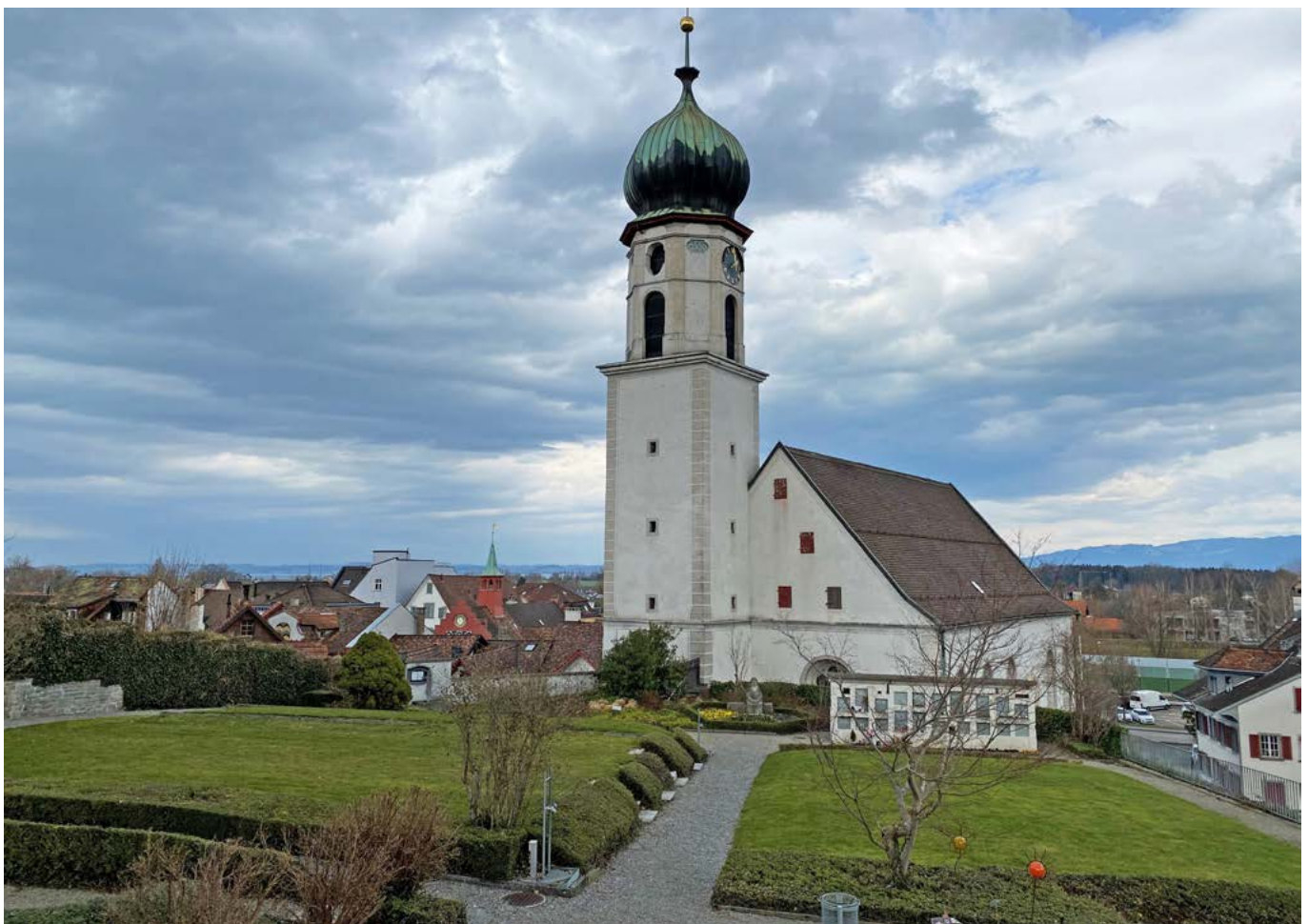
Eine Sanierung des Friedhofs wird angegangen.
