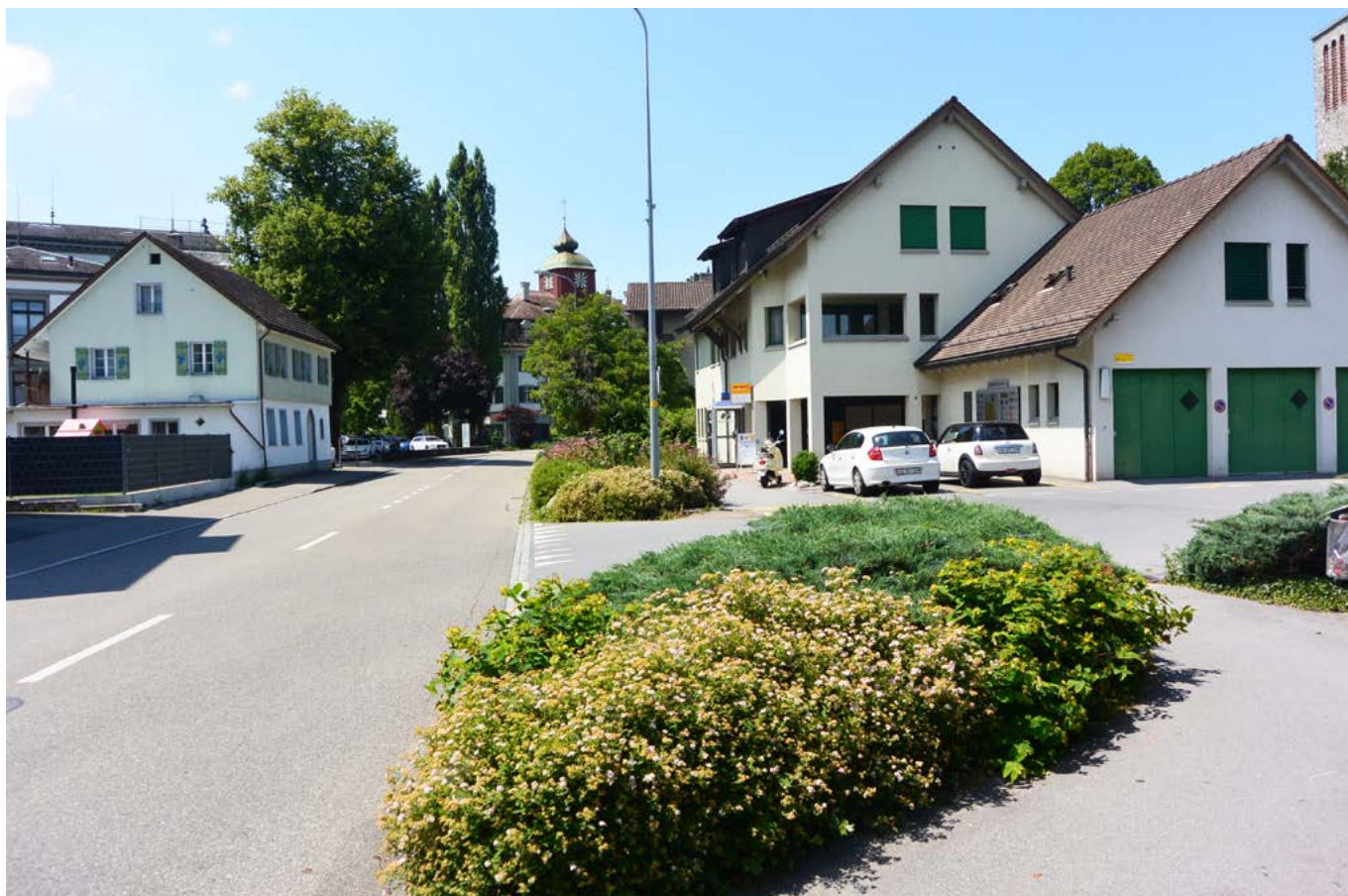
Die Rorschacherstrasse soll neu gestaltet werden
